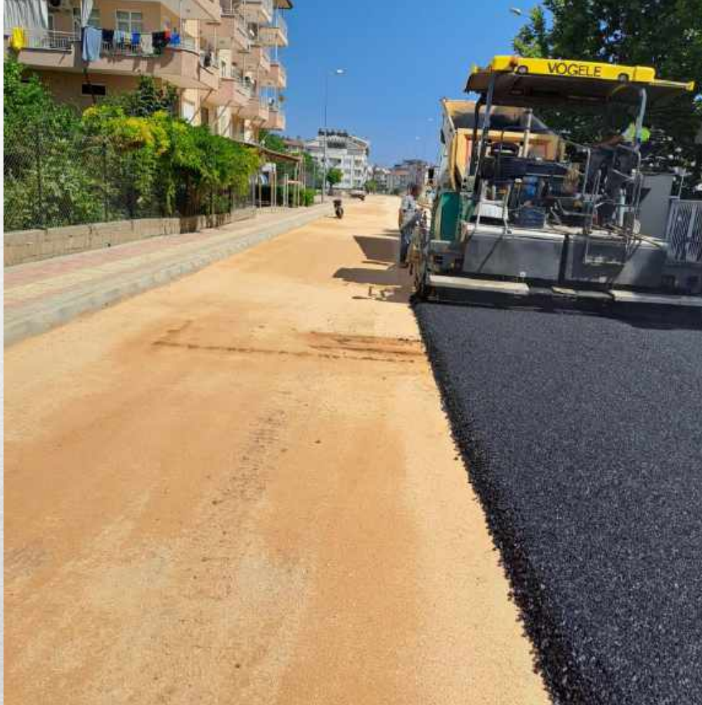
FOTOĐRAF 001: ÖRNEK MAH. SICAK ASFALT ÇALIŐMASI
