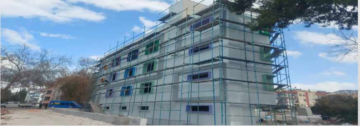
Fotoğraf 2: Türkan SÖZEN Kreş ve Gündüz Bakımevi Yapım Aşaması
