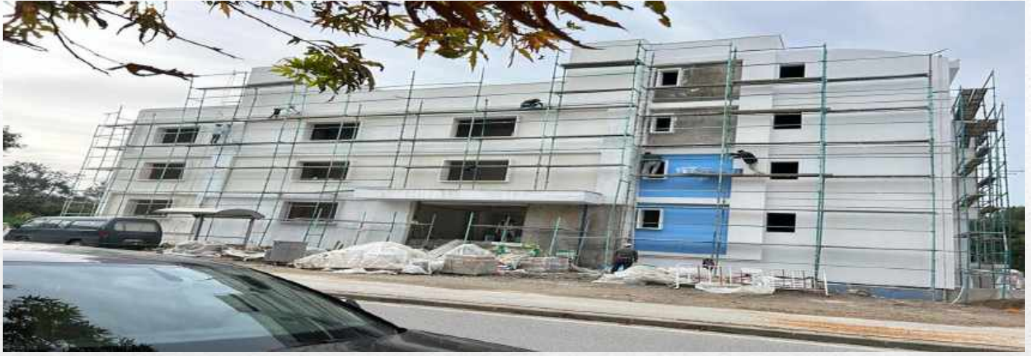
Fotoğraf 1: Türkan SÖZEN Kreş ve Gündüz Bakımevi Yapım Aşaması
