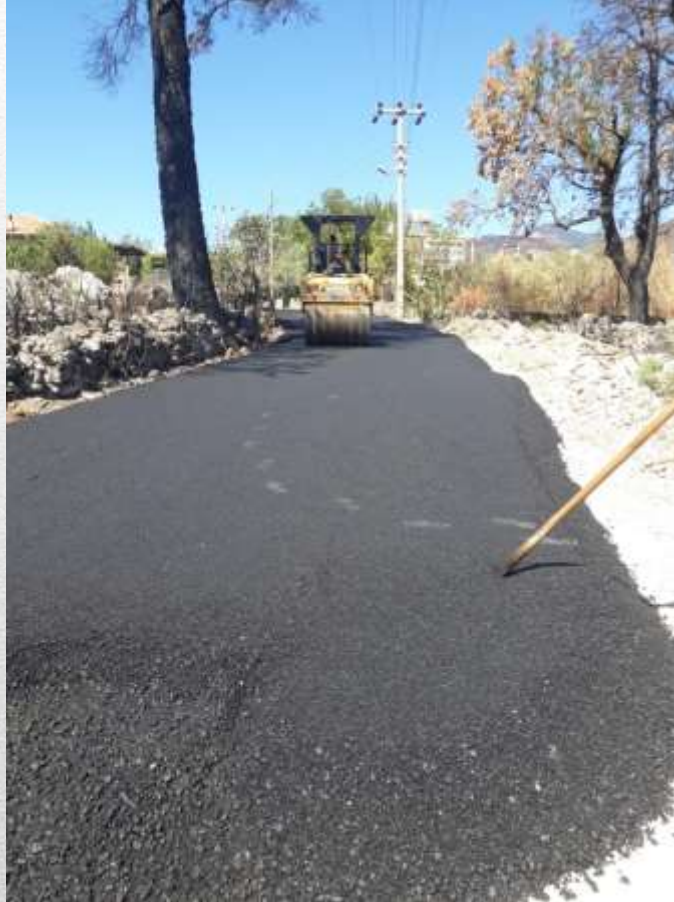
FOTOĞRAF 003: YAYLA ALAN MAH. SICAK ASFALT ÇALIŞMASI
