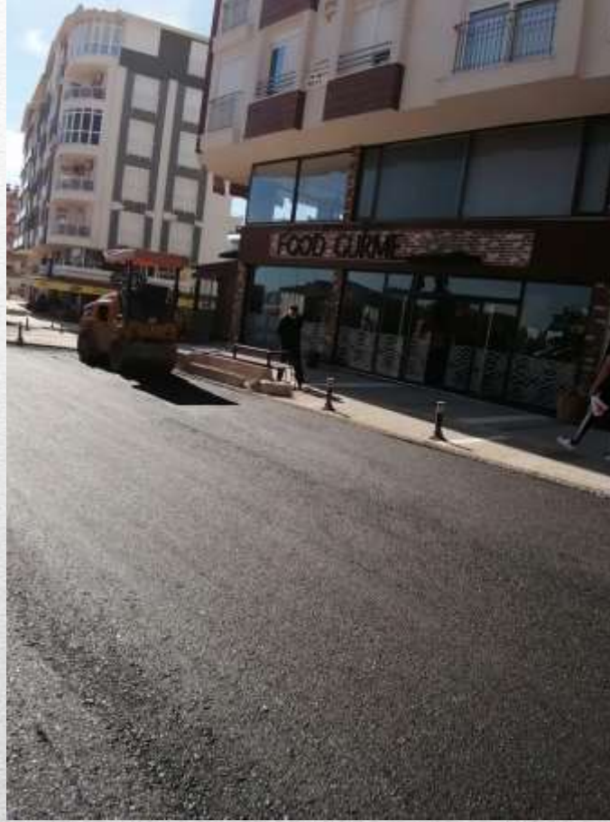
FOTOĞRAF 001: EMEK MAH. BARBAROS CAD. SICAK ASFALT ÇALIŞMASI
