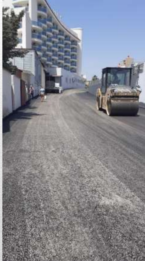
FOTOĞRAF 002: ILICA MAH. SICAK ASFALT ÇALIŞMASI
